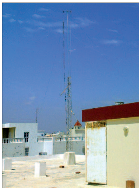
So fanden wir das Dach vor! Ein Beam und jeweils eine Groundplane für 40 m und 80 m schienen als Maximum möglich.
