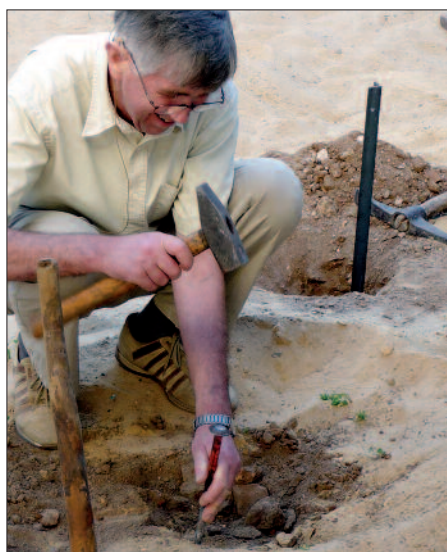
Gun, DJ9CB, bei der Arbeit am Erdungssystem der 160-m-Vertikal
