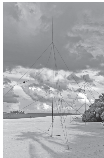
8Q7ZOのビーチサイドに立てられた160/80m インバーテッドL型アンテナ
